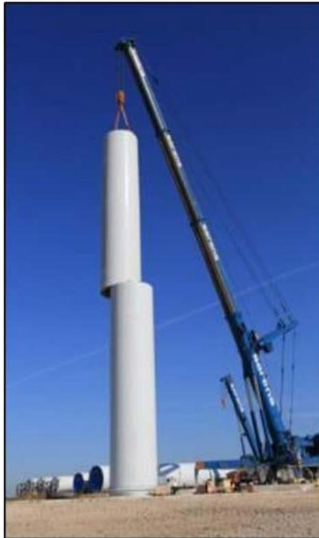
Figure 13 : Grues avant le levage du moyeu
