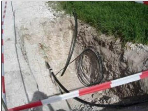
Figure 12 : Tranchée pour le passage des câbles électriques
