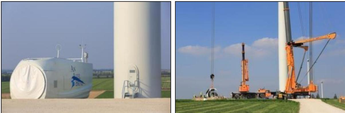
Figure 14 : stockage de composants avant l'assemblage
